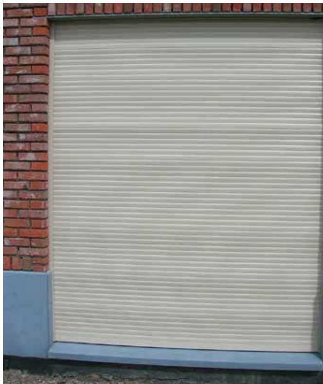
Bild 4: Welligkeit von Rollladenpanzern
